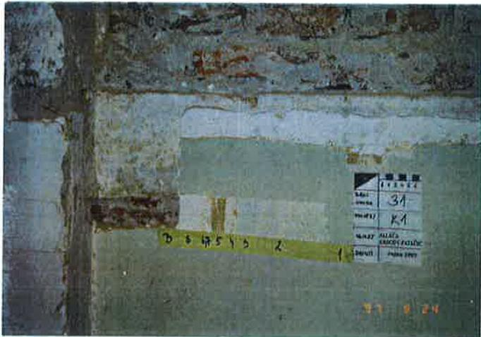
Sonda je otvorena na vanjskom zidu hodnika, u vrhu njegove parapetne visine. Ispod višestrukih naliča i tankog sloja vapnene žbuke pokazala se kameni pomno klesana zaključna ploča, dužine 80,5 cm, debljine 12,5 cm. Parapetni zid do visine kamenog zaključka građen je opekama, kao i zid kojim je zatvoren arkadni otvor iznad ploča.
