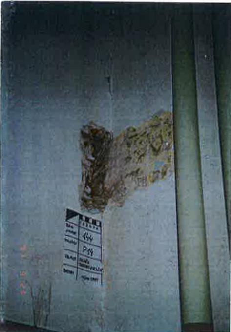
Sondom su uklonjeni naliči i posve tanki (do 2 mm.) žbukani sloj sa južnog zida prostorije, da bi se pokazale bočne fasadne površine palače iz 18. st., prijenego je uz nju, u 19. st. dodana prigradnja kojoj pripada i ova prostorija. Pokazala se stara erozijom načeta žbuka sa tragovima sivog te potom bijelog, hladnookerastog i dva oker vapnena naliča. Žbuka sa navedenim naličima bila je natučena u 19. st., prilikom nanošenja novog žbukanog sloja.
